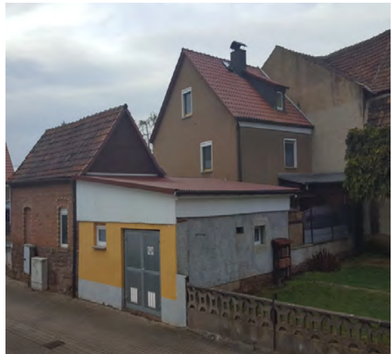
Anbau für Propangastank
